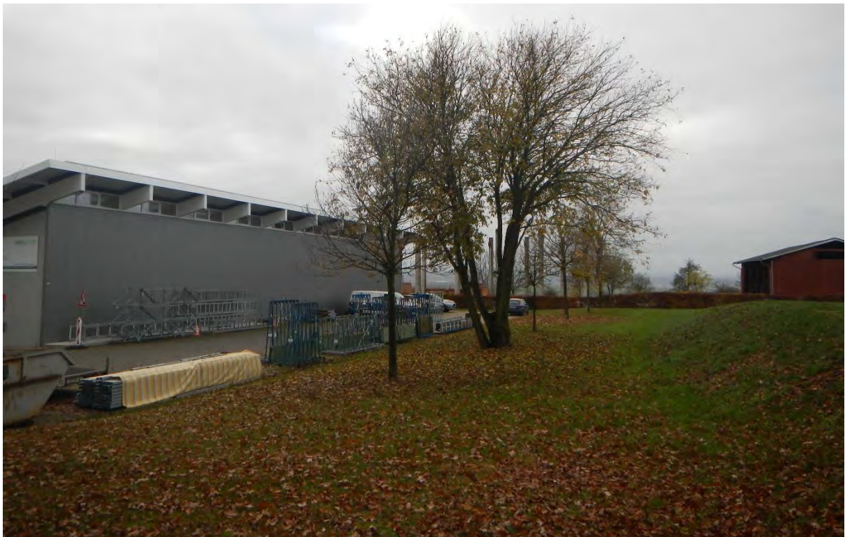
Abb. 13: Bestandsgebäude und Gehölzreihe im Nordosten des Plangebietes
